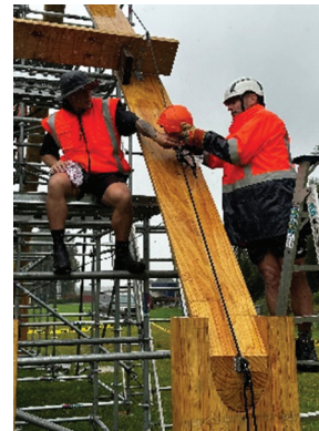
(d) Waterproofing of compromised load cell
