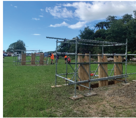
(d) Positioning of columns (poupou) prior to concrete placement
